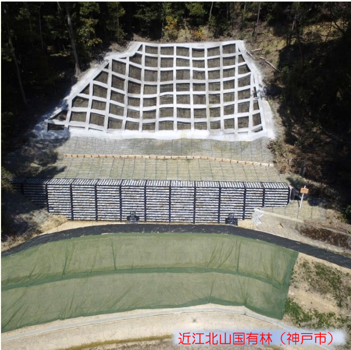
【山腹工等による復旧状況】
