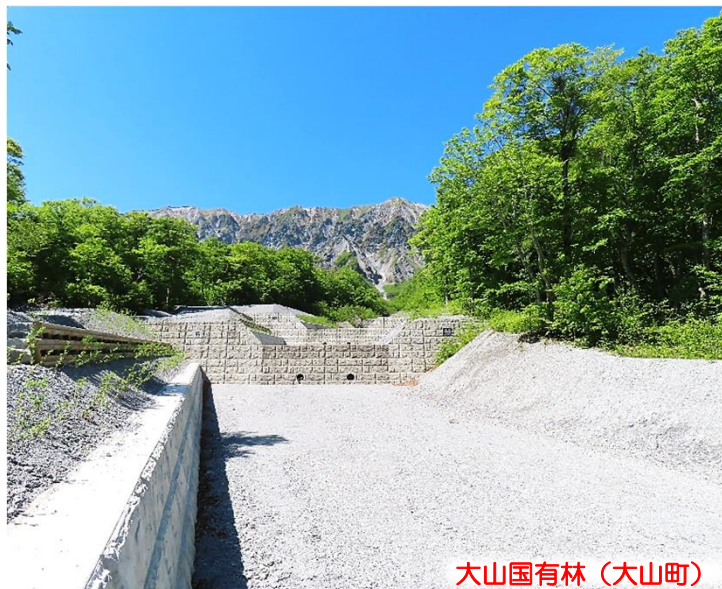
【二ノ沢に設置した溪間工・護岸工】
