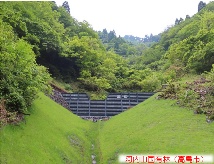
【 荒廃した溪流に施工した溪間工 】
