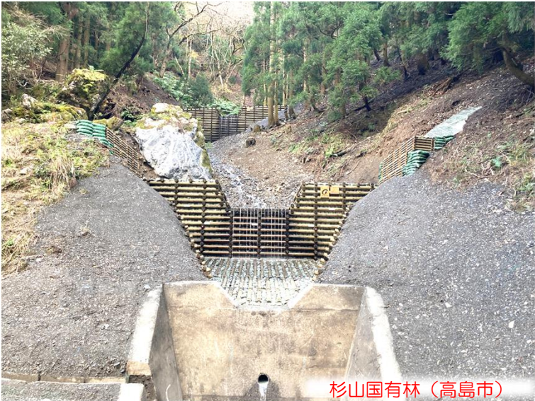
【 木材を利用して施工した溪間工 】
