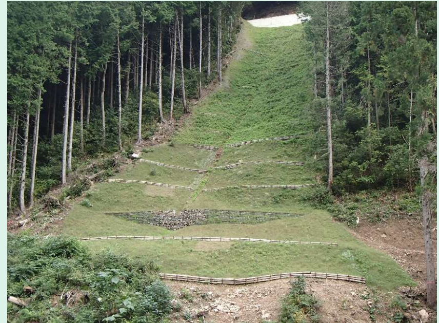
治山施設（山腹工）
