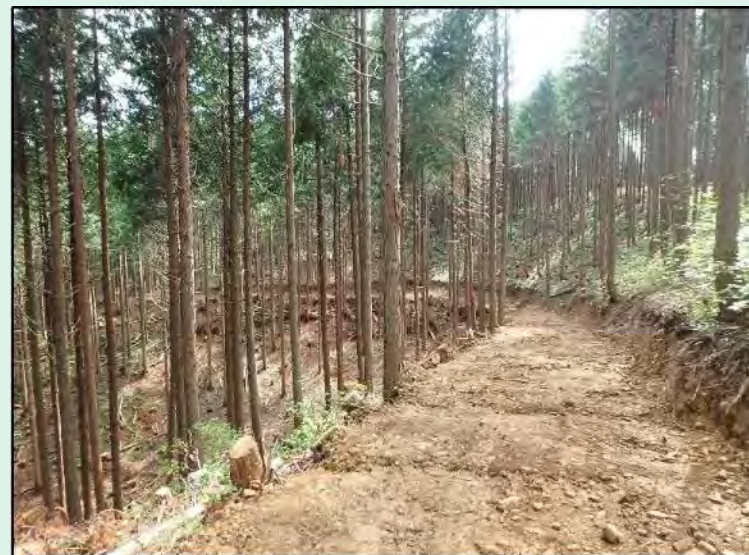
森林施業団地内での搬出間伐・路網作設の状況 (県営林(平見谷) 安芸太田町) 令和2年度実施
