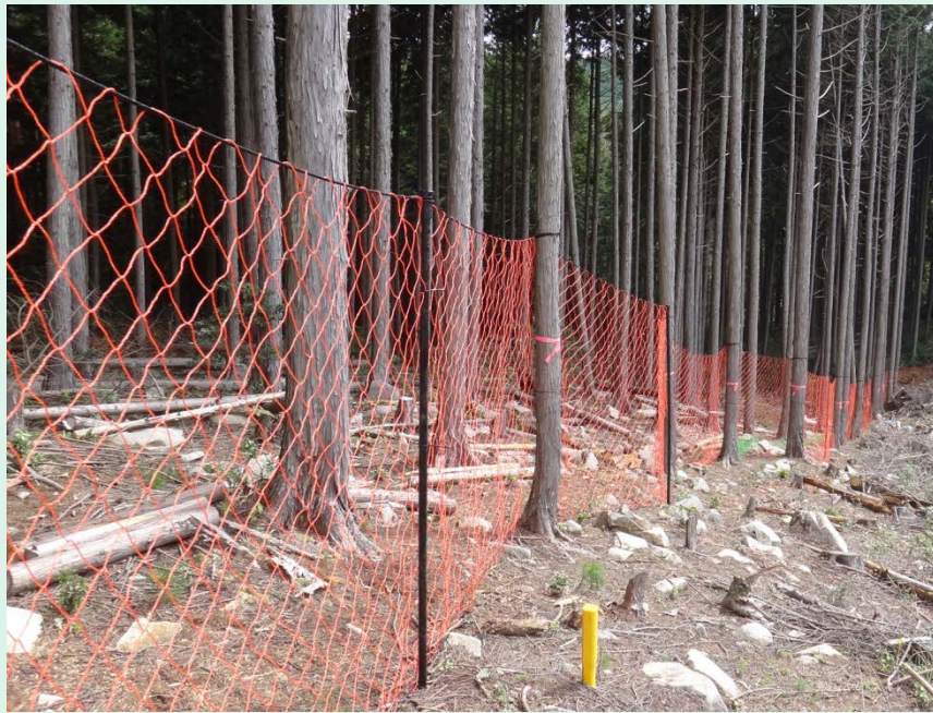
防護柵(立木利用) 大土山国有林(安芸高田市)
