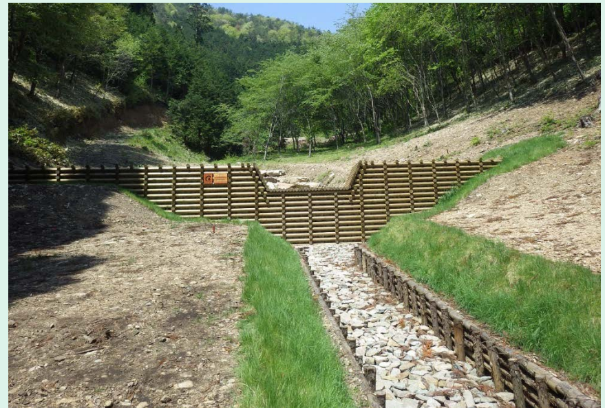
治山堰堤（校倉式）
