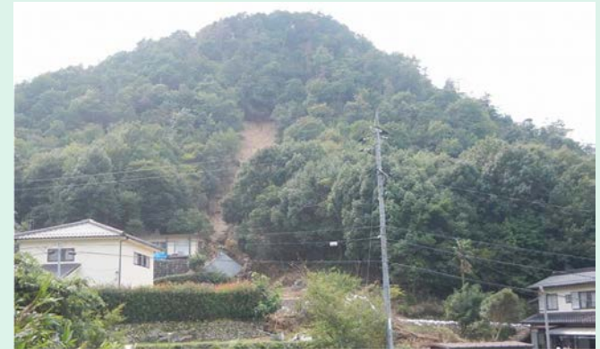
山腹工施行後
