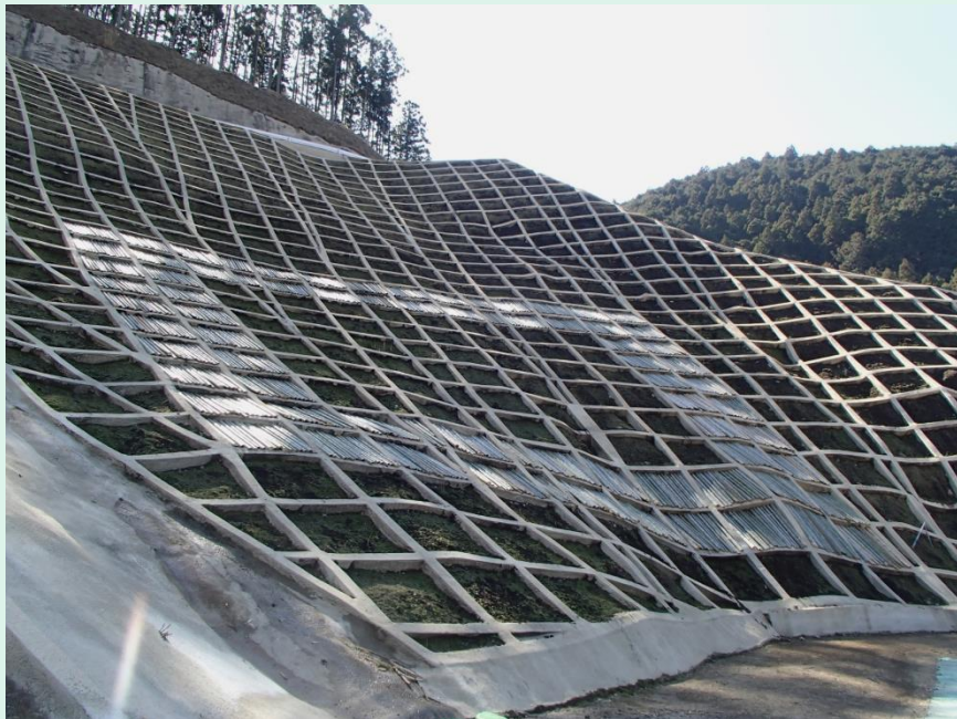
竹による防護柵設置状況
