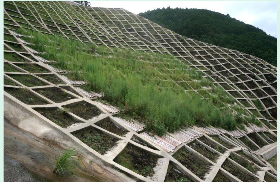
竹による防護柵設置半年後
