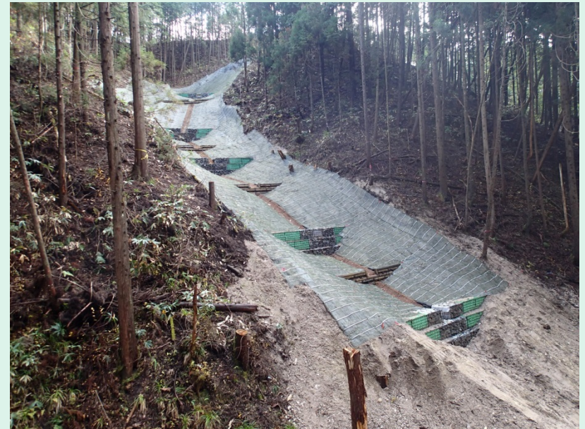
山腹工施工後
