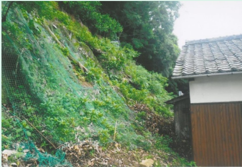
山腹工施工前
