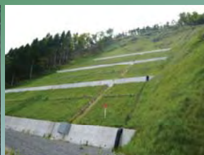
山腹工施工地 (那岐山国有林：吉井川)
