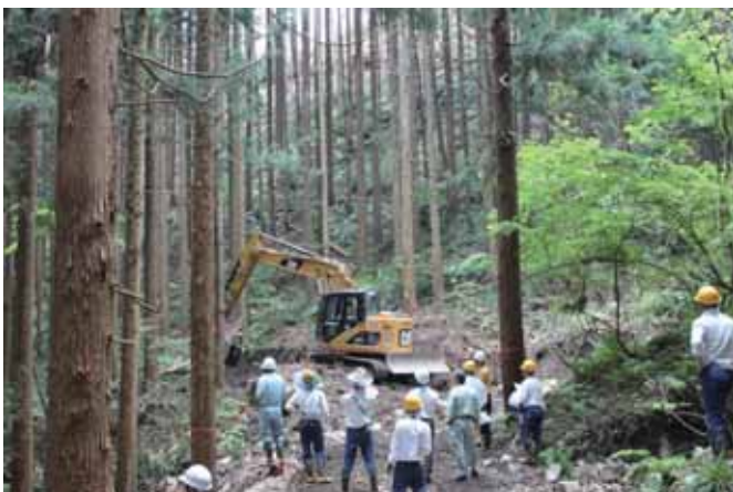
甲野村山地域森林共同施業団地 路網現地検討会(甲野村山国有林：庄原市)
