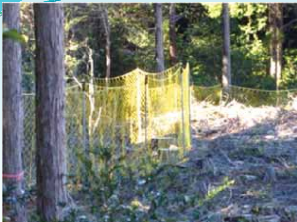
防護柵の設置 (江の川上流:大土山国有林:安芸高田市)
