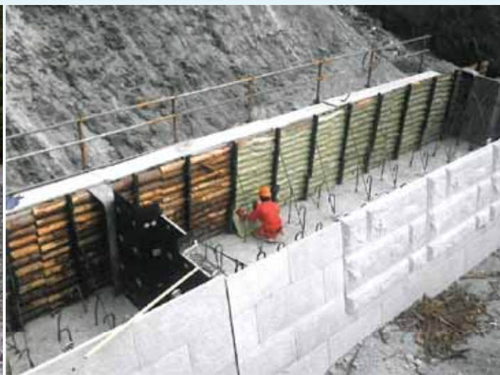
間伐材の治山事業での積極的利用 (大山国有林：大山町)
