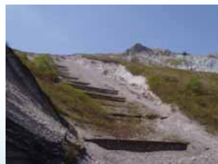
山腹工施工地 (日野川:大山国有林:大山町)
