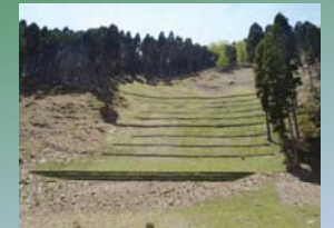
山腹工施工地 (攝保川：阿舎利国有林：穴栗市)
