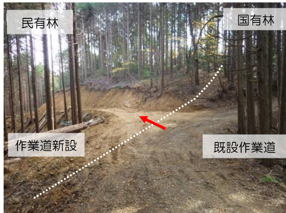
民有林連携した作業道（民有林作業道新設）
