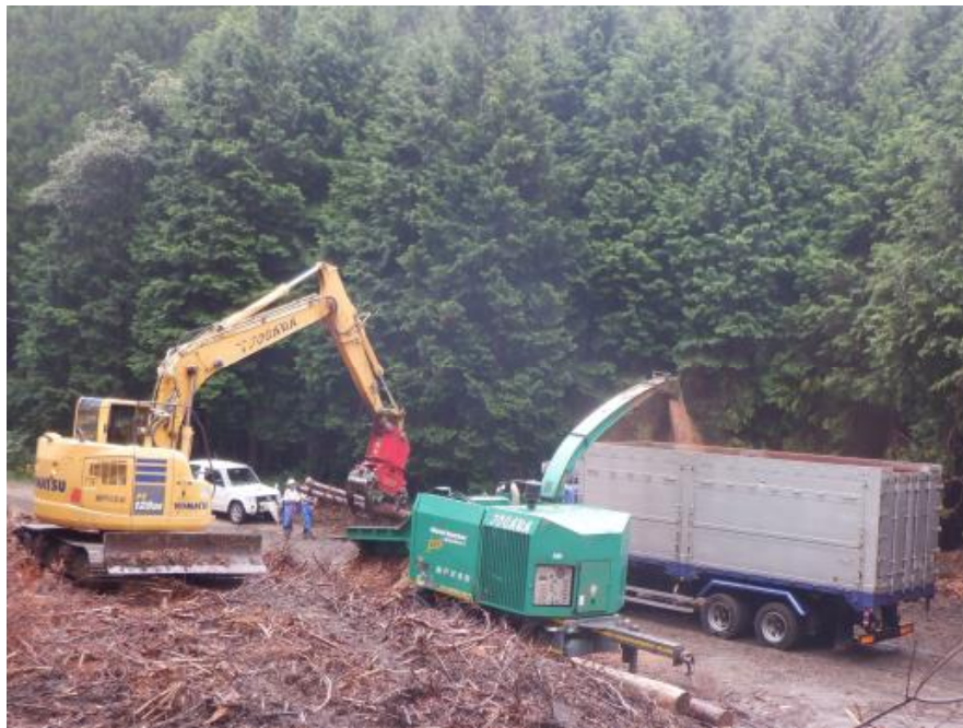
樹木採取区での作業状況 (高梁川下流：樋谷山国有林：新見市)
