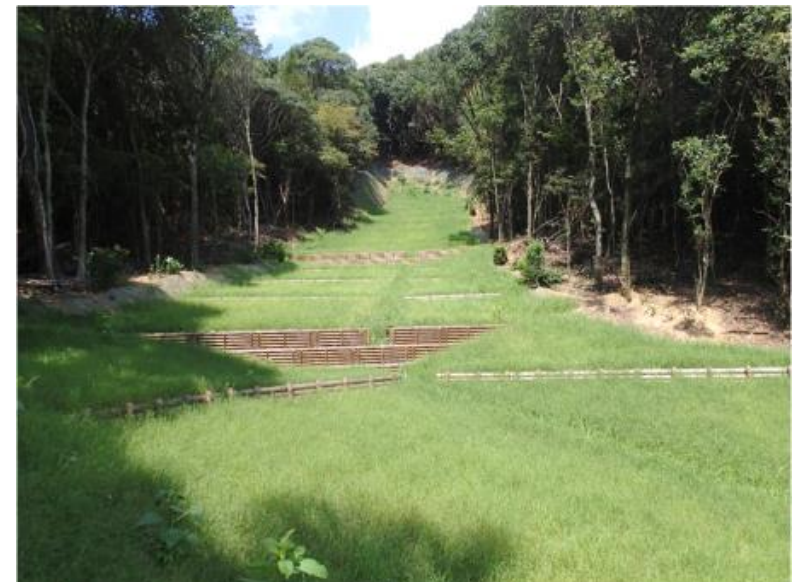
山腹工施工地 (高梁川下流：加賀山国有林：浅口市)
