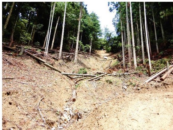
【山腹工施工前】
