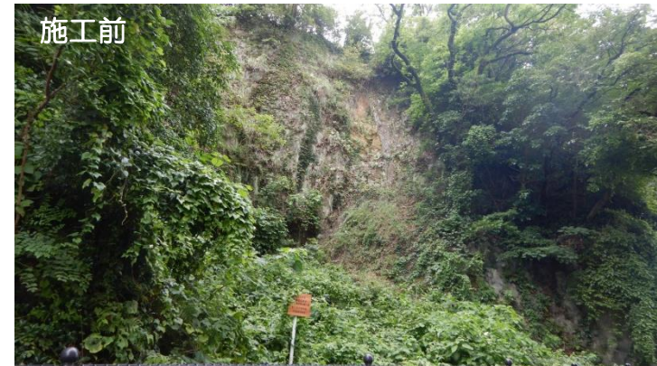
【道路沿いの山腹斜面に施工した山腹工】
