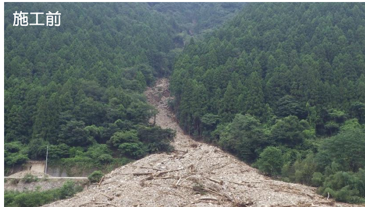
【豪雨により被災した山腹斜面の溪間工】
