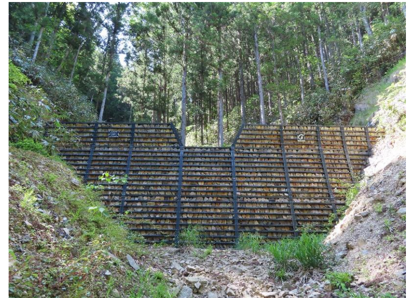
溪間工施工地 (高津川：栴谷山国有林：吉賀町)
