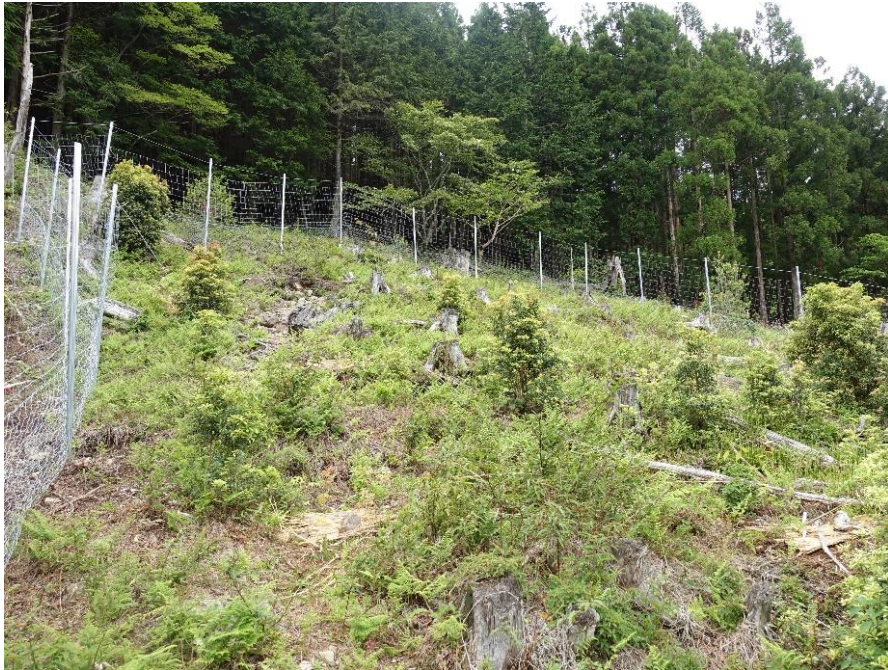
防護柵の設置 （南伊勢：大杉谷国有林：大台町）
