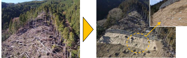
▲【京都府京都市 貴船山国有林：山腹工 復旧状況】
