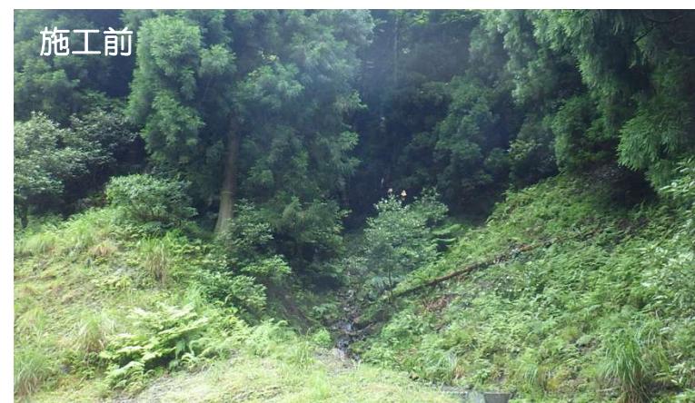
【木材を利用して施工した溪間工】
