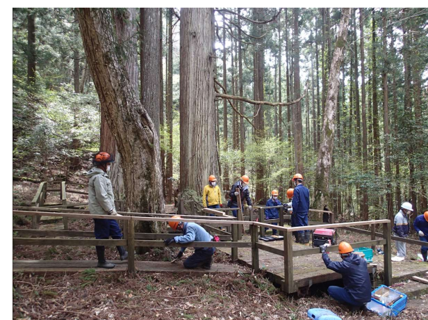
遊歩道木板の苔落としや手すりの補修
