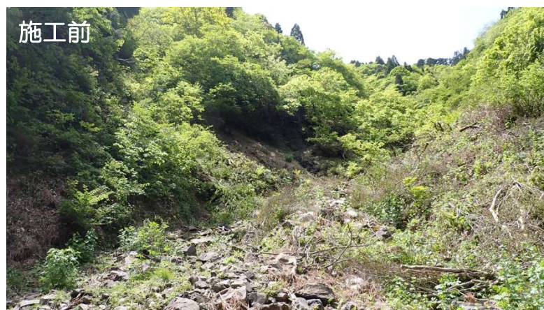
【荒廃した溪流に施工した溪間工】
