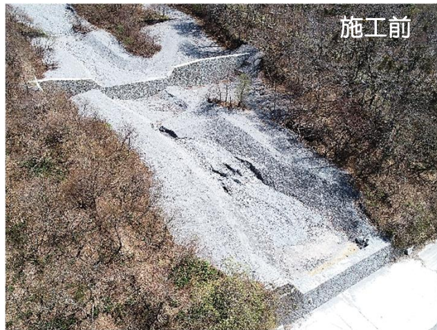
【溪間工（床固工）復旧状況】
