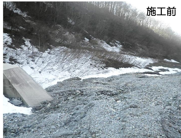
【溪間工（護岸工）復旧状況】
