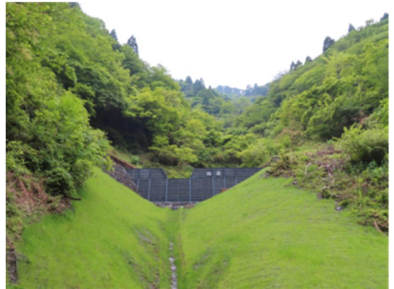
溪間工施工地 (湖北：河内山国有林：高島市)
