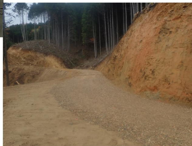
施業団地内に開設した林業専用道 (江の川上流：甲野村山国有林：庄原市)
