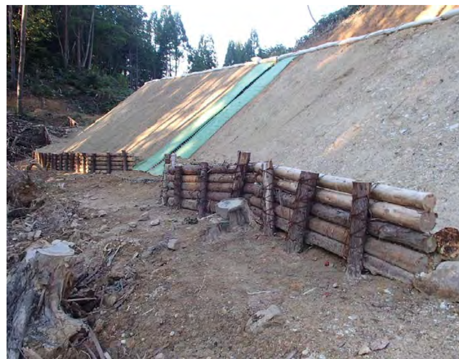
林業専用道の法尻の土留めに利用した木柵 (犬伏山国有林：安芸高田市)
