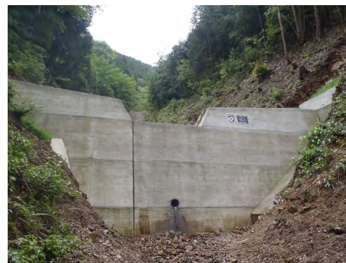
治山ダム施工地 (江の川下流：今山国有林：美郷町)
