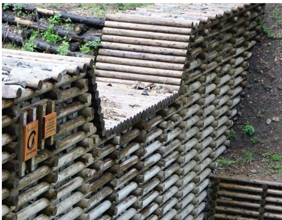
間伐材を使用した校倉式谷止工 (釜ヶ峰山国有林：庄原市)
