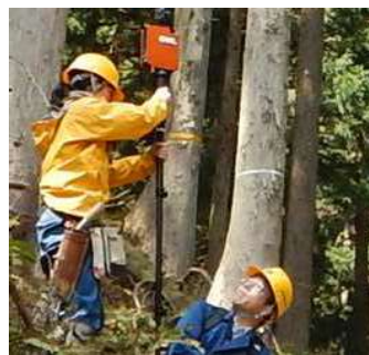
地上レーザ測量
