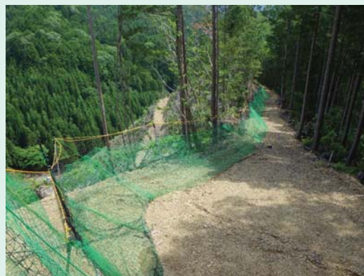
防護柵設置(斜め張り)
