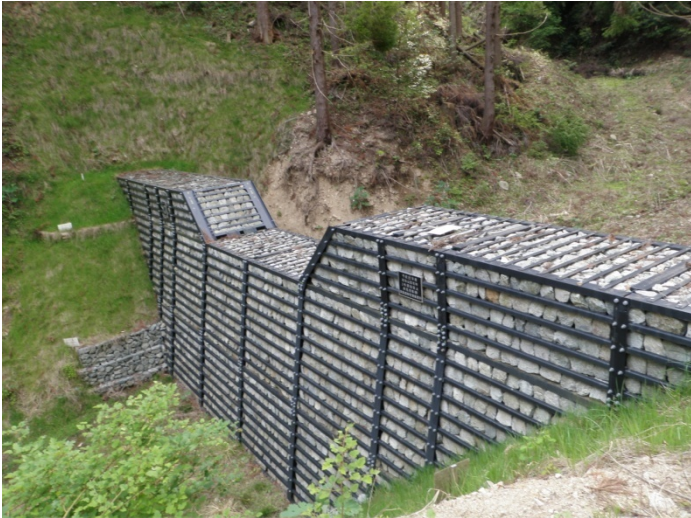
鋼製谷止工施工地：高取山国有林（大淀町）
