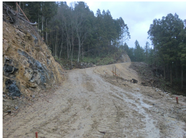
林業専用道新設箇所 ：中ノ甲国有林（安芸太田町）
