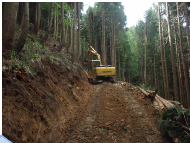
森林作業道作設
