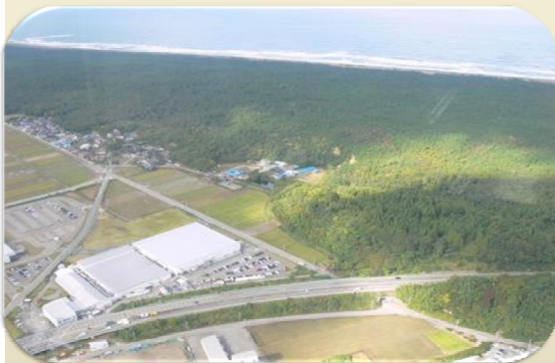
住宅、農地、工場、高速道路を保全している 加賀海岸国有林等の海岸林（写真－５）
