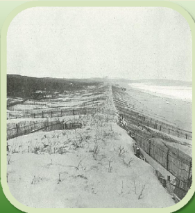
前丘の翼砂垣の設置状況(写真-4)
