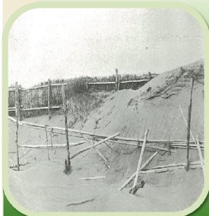
暴風により破壊された前丘(写真-3)
