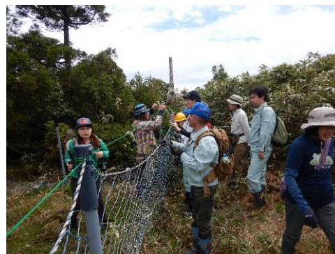
防護柵設置作業 おくやま 【奥山国有林（養父市）】
