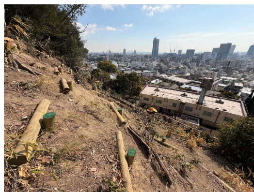
令和7年度施工 木杭打工 どうとくやま 【堂徳山国有林（神戸市）】
