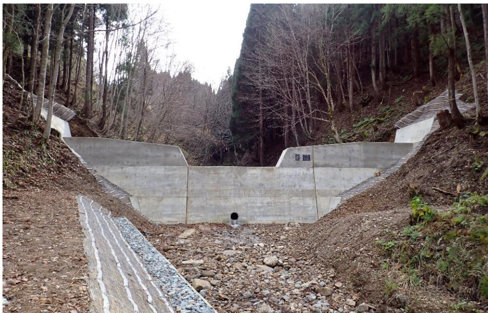
令和7年度施工 治山ダム くわがせん 【桑ヶ仙国有林（香美町）】
