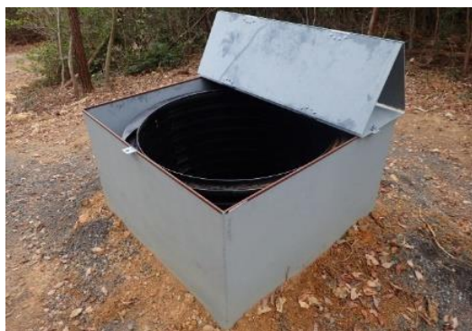
大型排水管を活用したシカ埋設処理施設 しんぐうたきたに 【新宮滝谷国有林（たつの市）】
