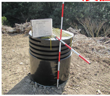
埋設した大型排水管
