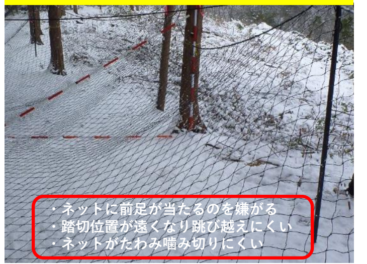
防護柵（斜め張り）の設置状況 備前市（岡山森林管理署管内）
