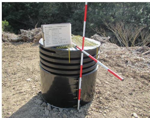
埋設した大型排水管
