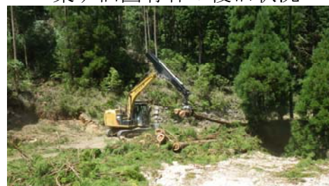
集材作業（阪水国有林）
