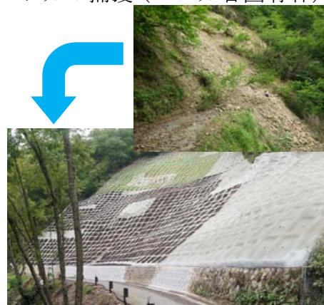
桑ヶ仙国有林の復旧状況
