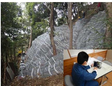
城山国有林山腹工事と遠隔臨場の試行の様子
