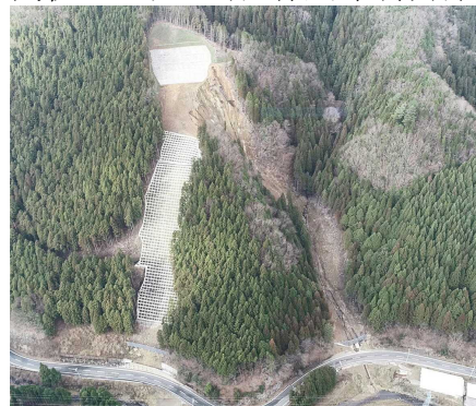
戸倉東山国有林の復旧状況
