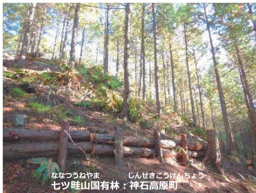
【本数調整伐※、丸太筋工】
