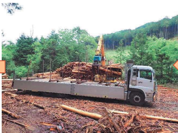
【トラック運搬作業】
