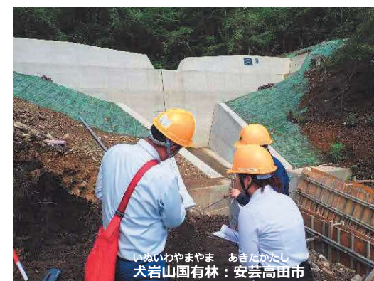
【大学生職場体験（治山工事現場見学）】
