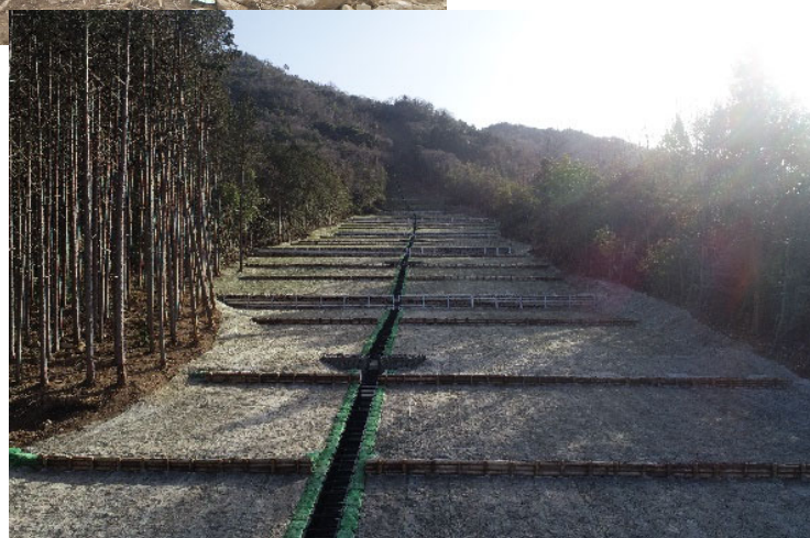
東広島市 高屋区域→ 山腹工事 完成状況
