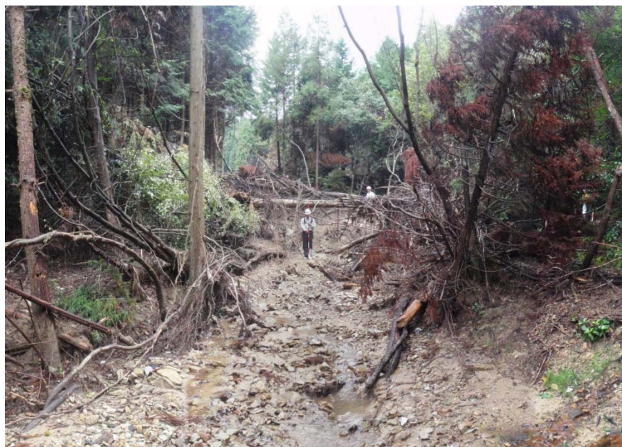
【工事前の溪流荒廃状況】
