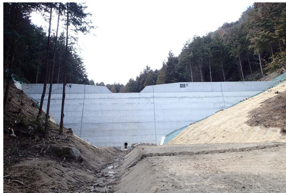
【治山ダム完成状況】
