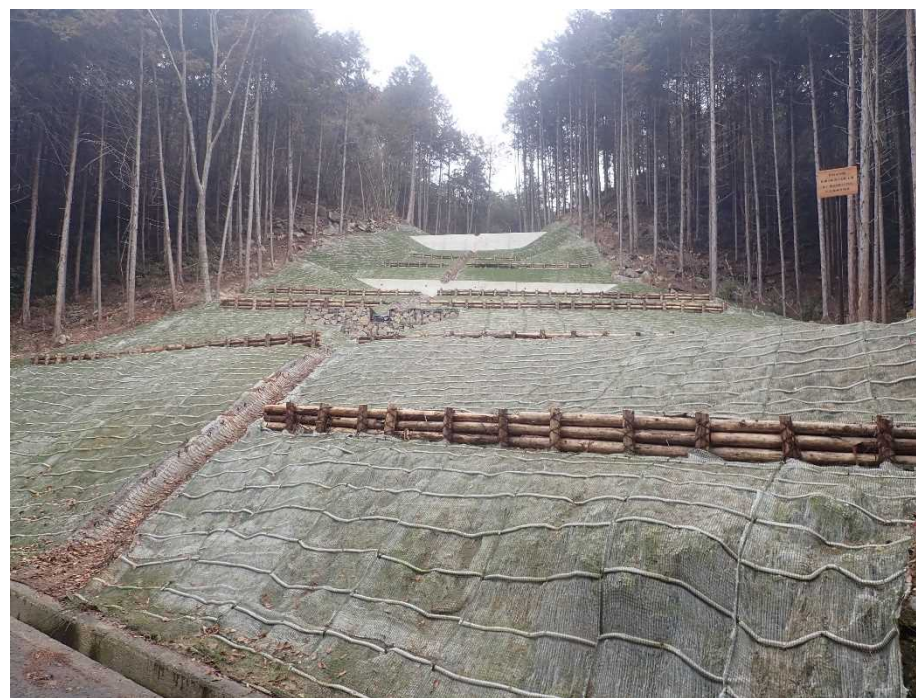
【山腹工完成状況】
