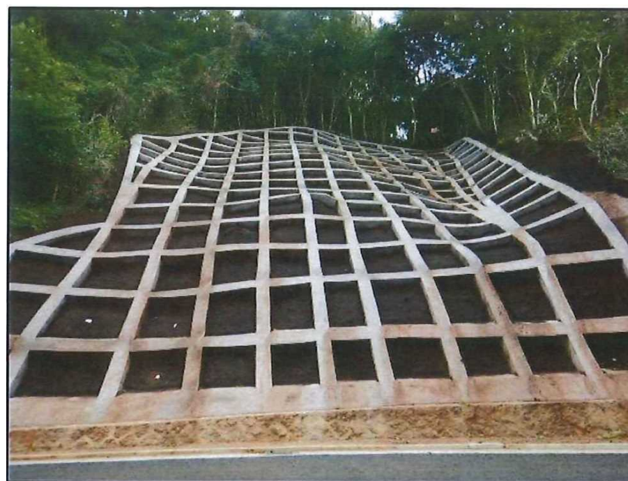
【山腹工完成状況】
