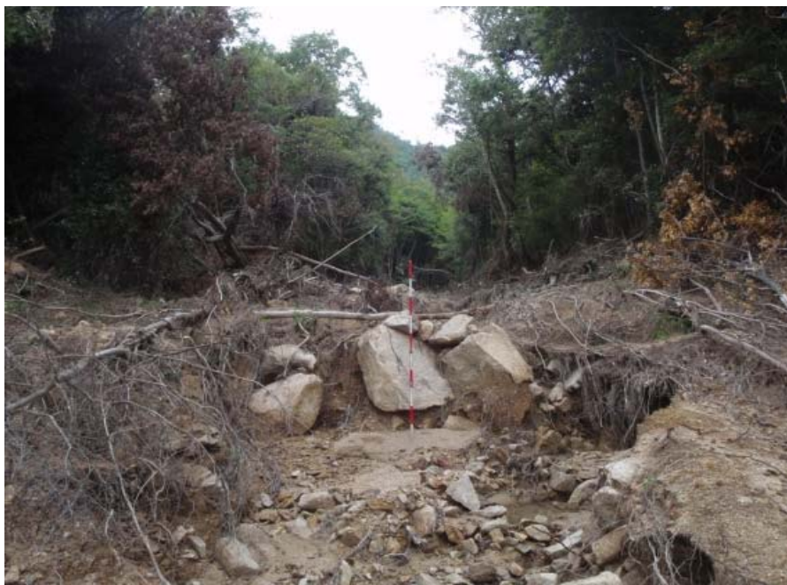
【工事前の溪流荒廃状況】
