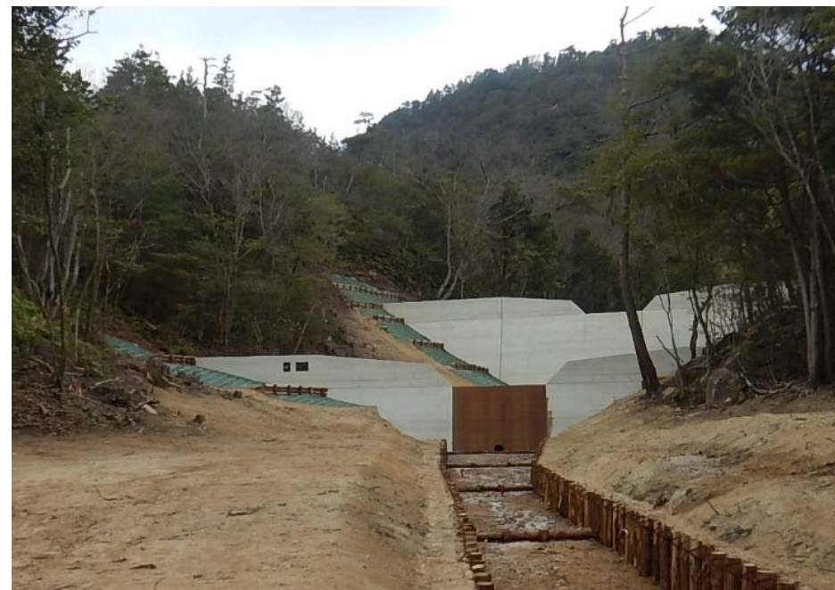
【治山ダム完成状況】
