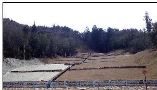
【完成状況】 高屋19
