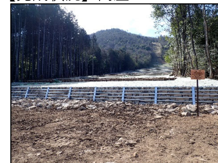
【完成状況】 高屋30
