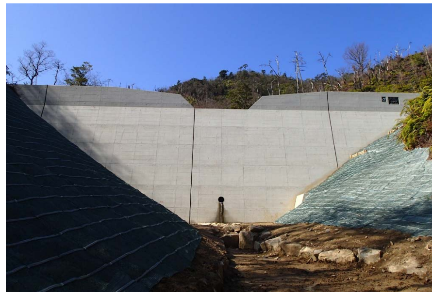
【治山ダム完成状況】
