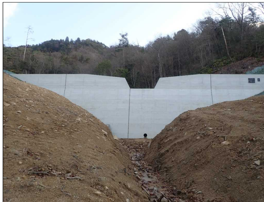
【治山ダム完成状況】
