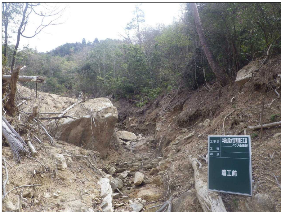
【工事前の溪流荒廃状況】
