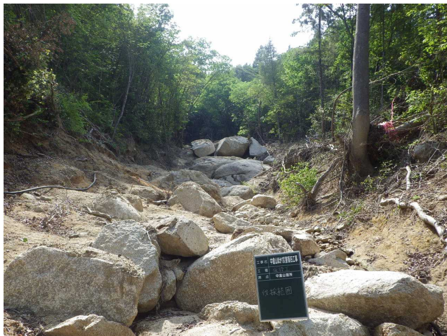
【工事前の溪流荒廃状況】
