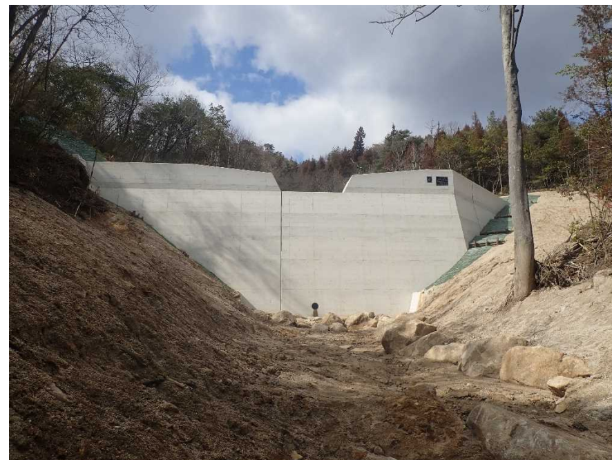
【治山ダム完成状況】
