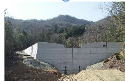
○工事概要：土石流安全対策工2基、治山ダム2基 コンクリート谷止工（4溪流：高さ8.5m・延長33.0m、7溪流：高さ9.0m・延長63.0m）
