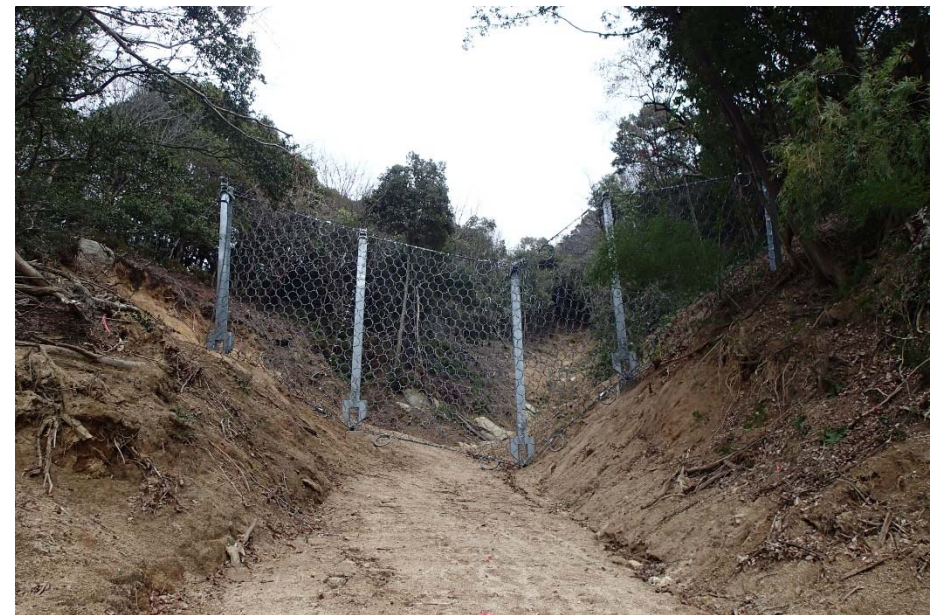
【土石流安全対策工 完成状況】
