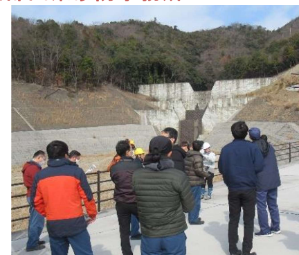
303溪流土石流堆積工
