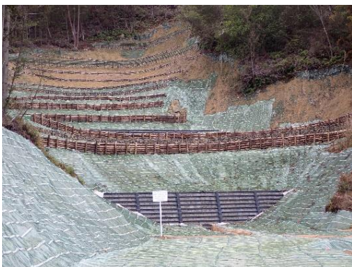
丸太筋工(東広島市:民有林直轄治山)
