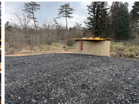
大型排水管を利用した捕獲シカ埋設施を北広島町が設置
