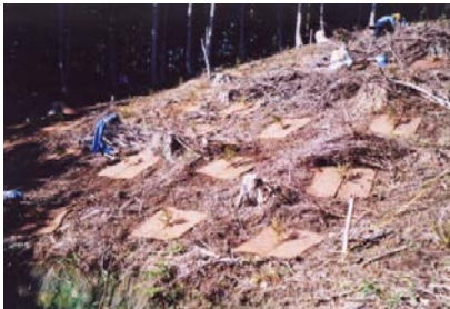
H16.12 バークマット敷設状況
