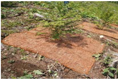
H17.03 バークマット敷設状況
