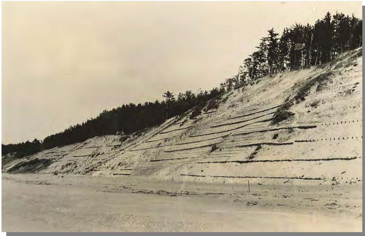
北潟の森の山腹斜面の復旧途中の様子(昭和30年代)
