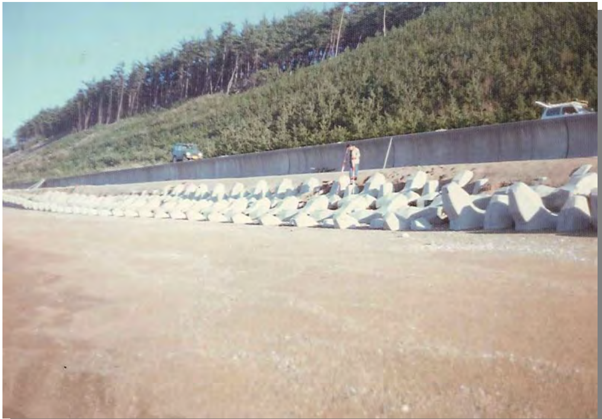
北潟の森を支える護岸工事(昭和50年代)
