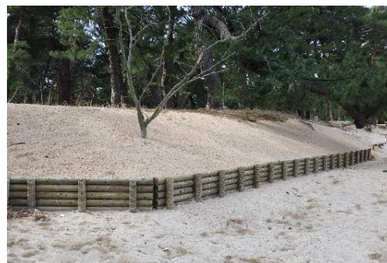
マツの土壌となる砂の流失を防ぐ養浜工 (敦賀市 松原国有林)
