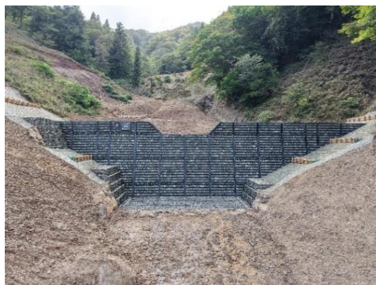
令和7年11月竣工 河内溪間工事 (若狭町 河内(こうち)国有林)
