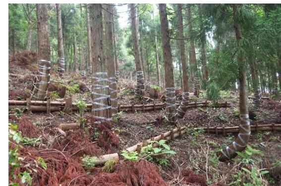
保安林整備 本数調整伐及び丸太筋工 (大野市 前坂国有林)
